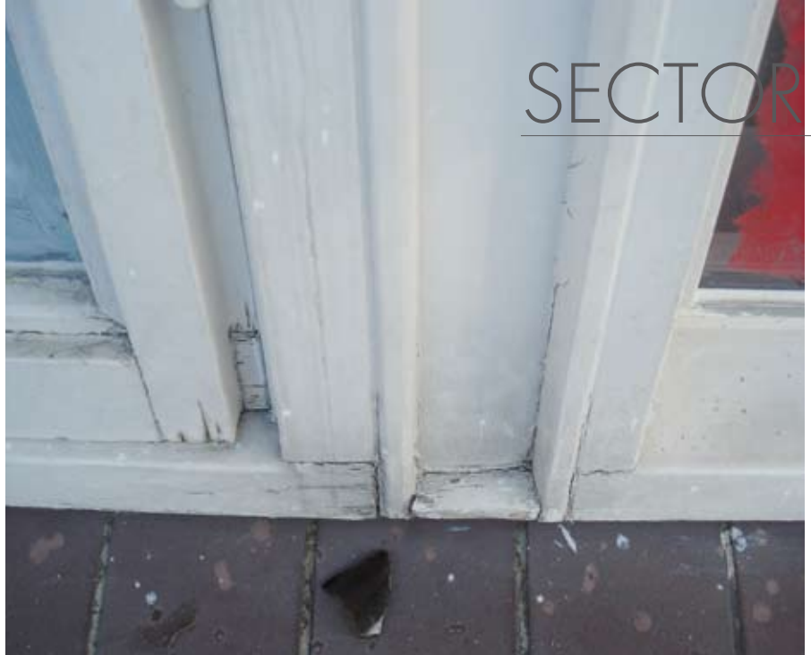
■ Voorbeeld van barstvorming als gevolg van slecht onderhouden schilderwerk.
